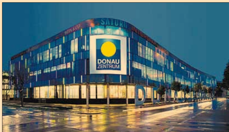
Zubau Wiener Donauzentrum: Das Gebäude wurde kürzlich mit dem breetam-Zertifikat als „sehr gut“ ausgezeichnet.
